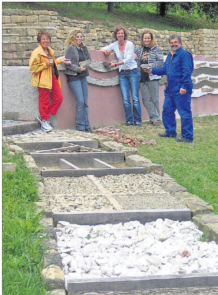
Wenige Tage vor der Einweihung der Anlage werden die letzten kleinen Arbeiten verrichtet.
