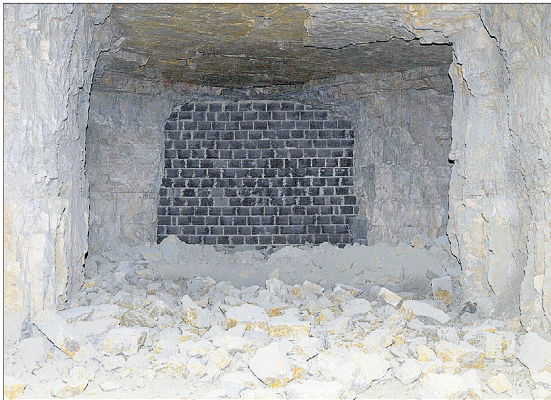
Statt stillgelegte Schächte zu vermauern, möchte die TKDZ diese mit überschüssigem Dolomitsand und Abfällen versetzen. Auch soll die Grube durch das Auffüllen von Hohlräumen stabilisiert werden. (FOTO: GERRY HUBERTY)
